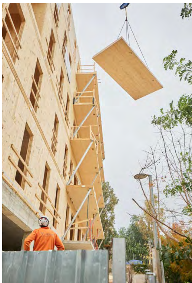
Construcció del projecte Cirerers d'habitatge cooperatiu
