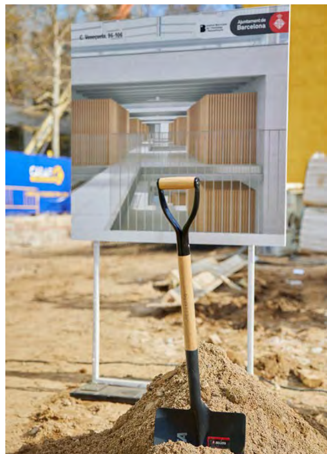
Solar en obres destinat a habitatge públic
