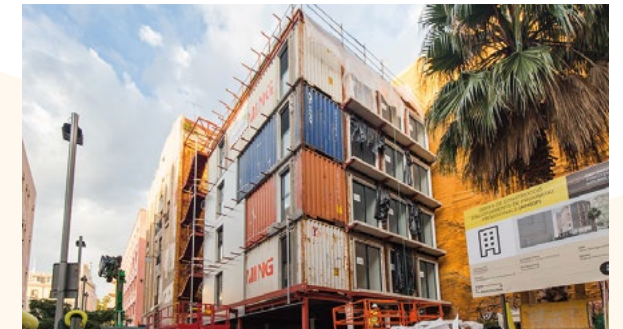
Procés de construcció APROP Ciutat Vella
