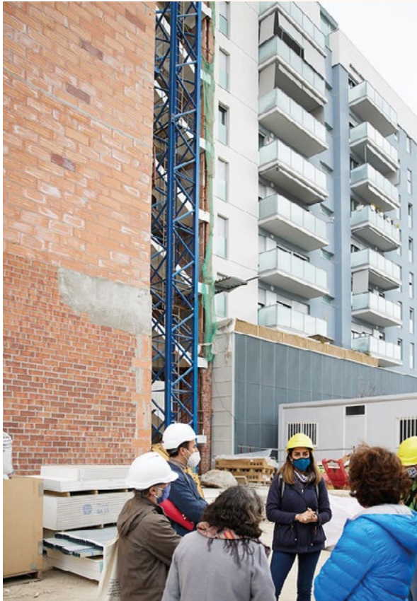
Visita obres, promoció La Chalmeta
