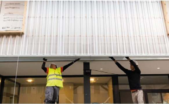
Procés de construcció APROP Ciutat Vella
