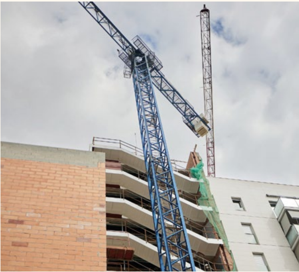
Procés de construcció La Chalmeta
