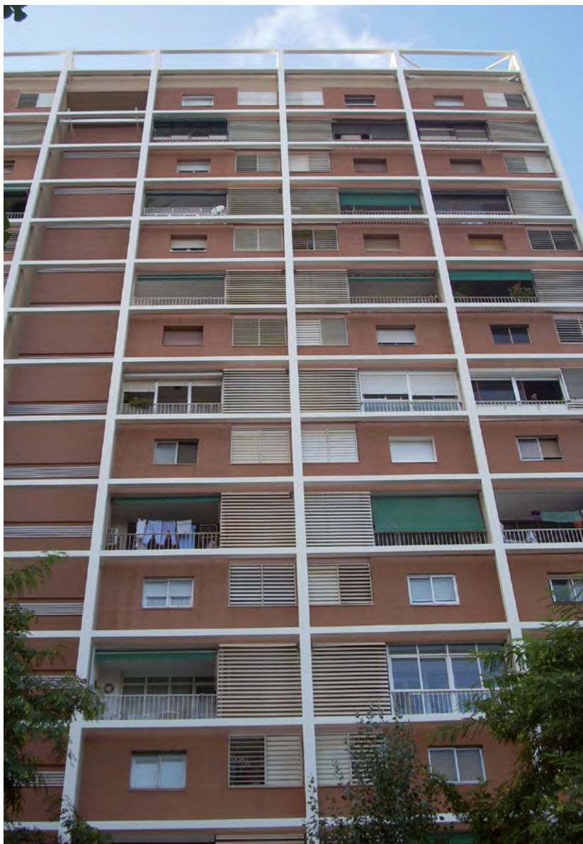
La mejora de las estructuras es un proceso necesario en barrios antiguos o degradados. En Cataluña hay casos pioneros, como la experiencia de Adigsa en la rehabilitación de las estructuras externas de los edificios de La Pau.
