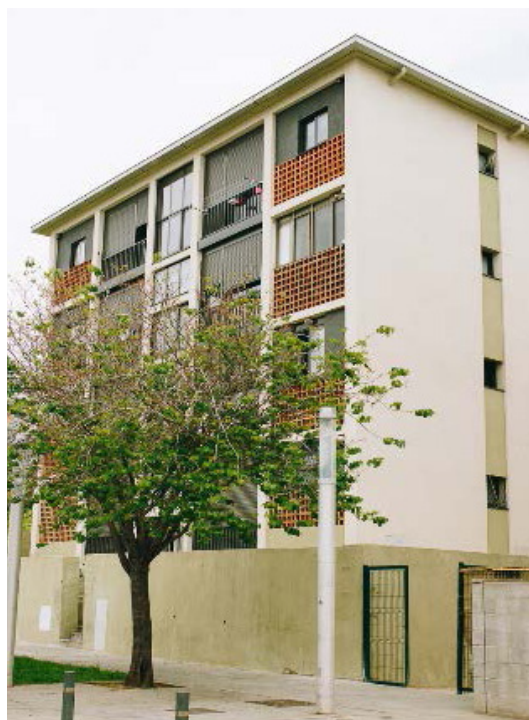
Rehabilitació Fortuna la Marina
