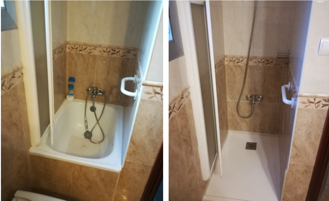
Transformació d'un interior per facilitar l'accessibilitat
