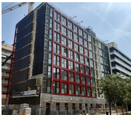
APROP de Glòries, en construcció
