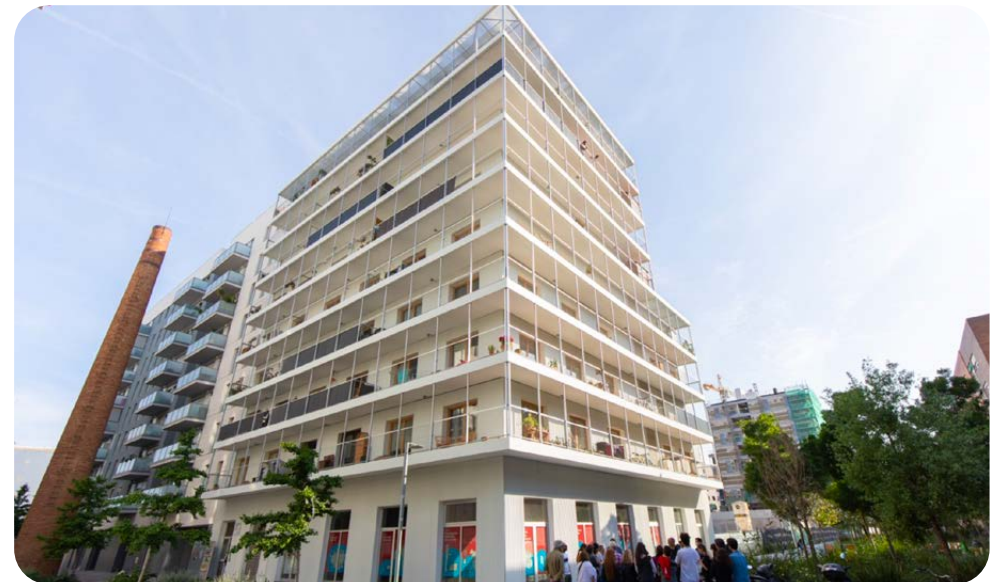
La Chalmeta, Cooperativa de vivienda en suelo municipal Fuente: Institut Municipal de l'Habitatge i Rehabilitació de Barcelona
