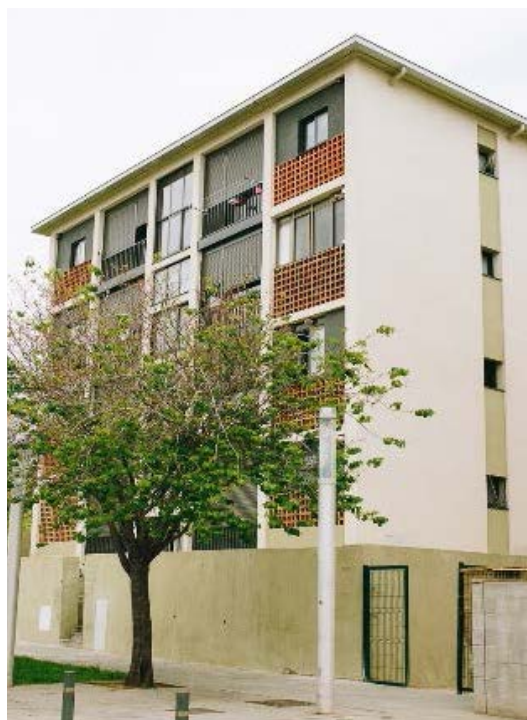
Rehabilitación Fortuna, la Marina
