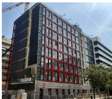
APROP de Glòries, en construcción
