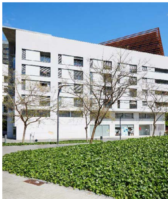
Calle de Granada, casal de barrio y viviendas con servicios para personas mayores
