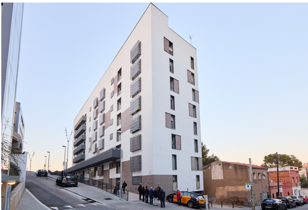
Edifici del parc públic de l'IMHAB rehabilitat de manera integral al c. Trueba, 27
